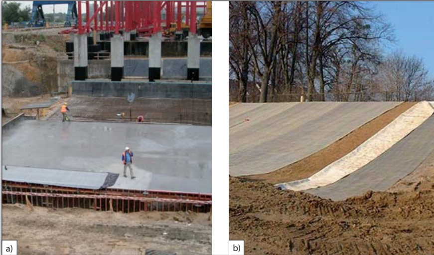
Rys. 4 | Hydroizolacje z mat bentonitowych: a) izolowanie fundamentów, b) izolowanie składowisk odpadów [fot. z materiałów firmy Lemax].
