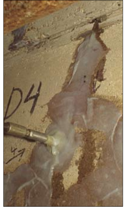
Przykładowy sposób i miejsce zastosowania węży iniekcyjnych WEBAC
