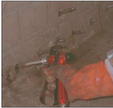
Przykładowy sposób i miejsce zastosowania węży iniekcyjnych WEBAC
