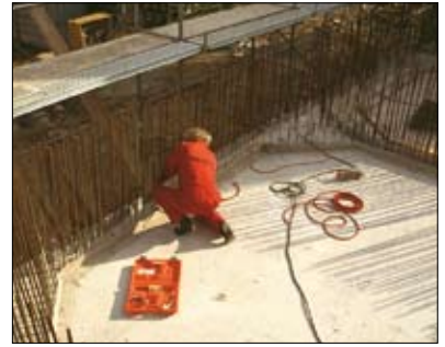
Przykładowy sposób i miejsce zastosowania węży iniekcyjnych WEBAC
