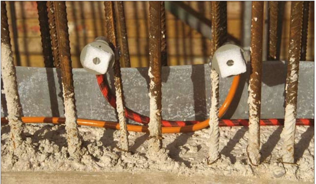
Instalowanie końcówek wyprowadzających do węży iniekcyjnych
