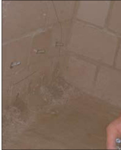
Modelowy sposób wykonania iniekcji kurtynowej
