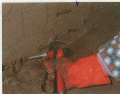
Fot. 1. Wykonywanie iniekcji ciśnieniowej w 80-letnim budynku w Tagermunde
