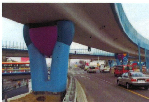
Przykład obiektu referencyjnego, w którym zastosowano produkty firmy WEBAC.
