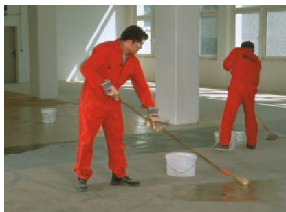
Fot. 1. Przykładowy sposób nanoszenia środka gruntującego WEBAC 4270
