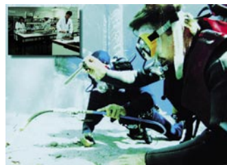
Zdjęcie 7: Wykonywanie uszczelnień metodą iniekcji ciśnieniowej pod wodą.
