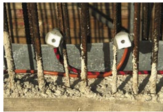
Zdjęcie 6: Przykładowy sposób układania węży iniekcyjnych.
