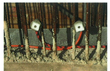
Zdjęcie 6: Przykładowy sposób układania węży iniekcyjnych.
