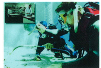
Zdjęcie 7: Wykonywanie uszczelnień metodą iniekcji ciśnieniowej pod wodą.
