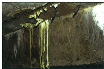
Zdjęcie 1: Przykład zastosowania spianialnej żywicy poliuretanowej zatrzymującej wycieki wody pod ciśnieniem.
