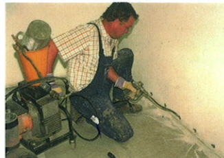
Zdjęcie 3: Operator pompy iniekcyjnej w trakcie procesu tłoczenia żywicy iniekcyjnej.
