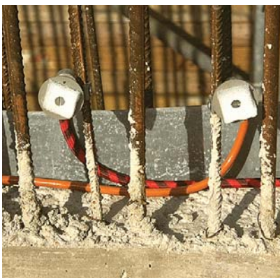
Fot. 4. Układanie węży iniekcyjnych
