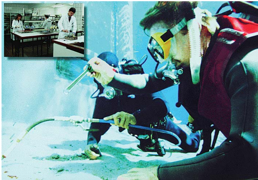
Fot. 3. Wykonywanie uszczelnień metodą iniekcji ciśnieniowej pod wodą
