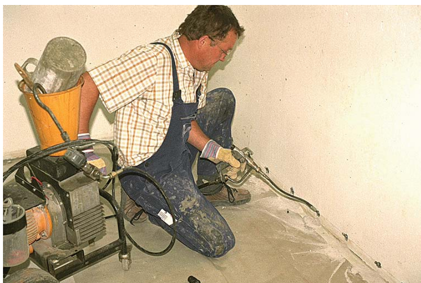
Fot. 2. Tłoczenie żywicy iniekcyjnej w celu utworzenia przepony poziomej
