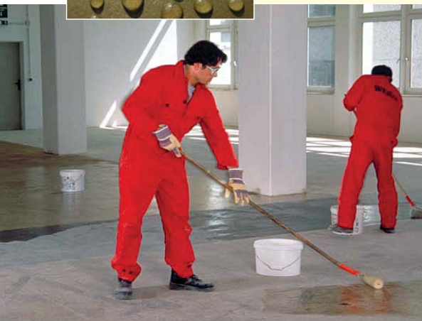
Nanoszenie środka gruntującego
