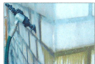
Rys. 7. Wysycenie struktury muru iniektem
