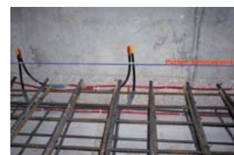
Zdjęcie 6: Przykładowy sposób układania węży iniekcyjnych.
