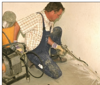
Wykonywanie prac iniekcyjnych – tłoczenie żywicy
