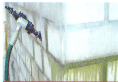
Wysycenie struktury muru iniektem
