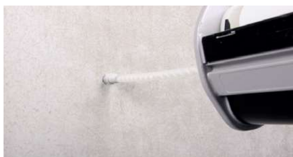
Statkmischer in den Packerstutzen setzen, anpressen und injizieren
