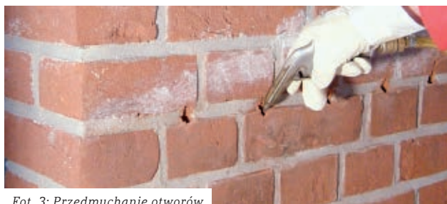
Fot. 3: Przedmuchiwanie otworów
