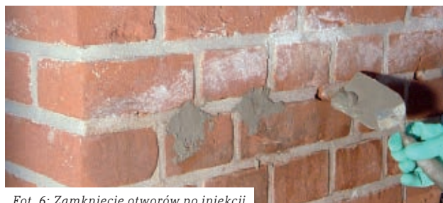
Fot. 6: Zamknięcie otworów po iniekcji
