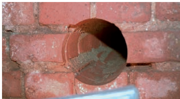
Otwór po wyjęciu rdzenia w murze ceglanym
