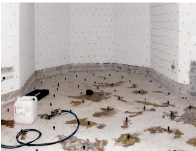
Układ iniektorów w podłodze i ścianach
