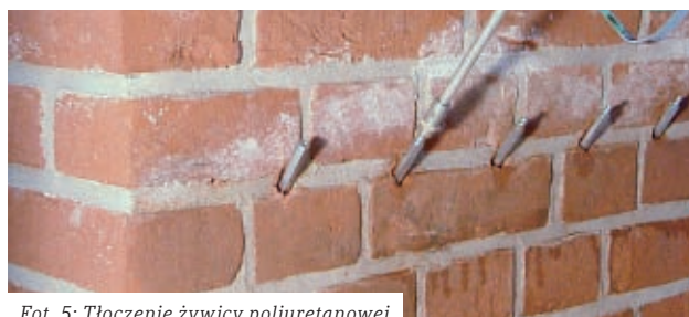
Fot. 5: Tłoczenie żywicy poliuretanowej
