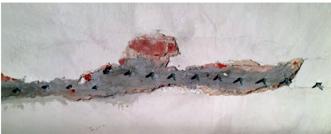
Układ montażu iniektorów
