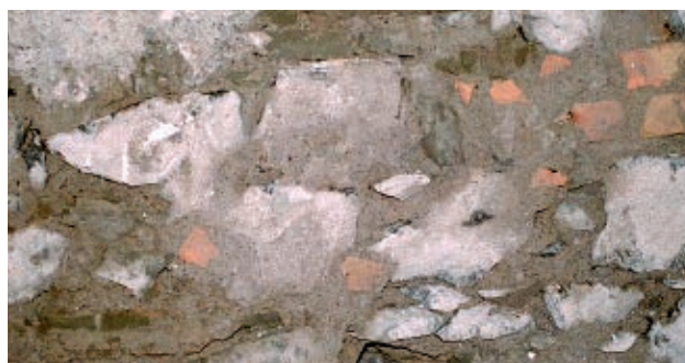
Mur kamienny na zaprawie glinianej
