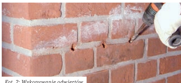
Fot. 2: Wykonywanie odwiertów
