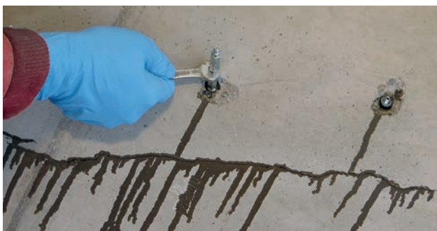
Foto. 5: Demontaż iniektorów
