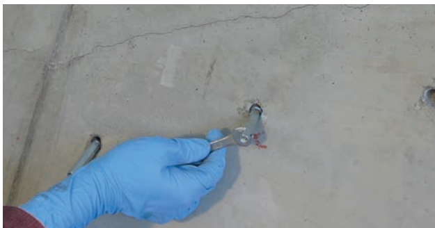
Foto. 3: Montaż iniektorów
