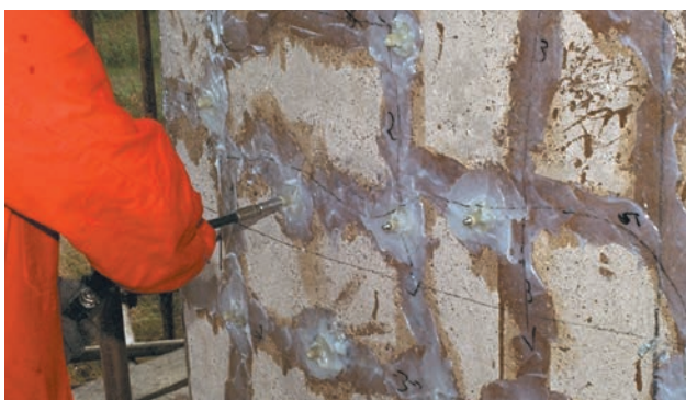
Iniekcja poliuretanową żywicą iniekcijną WEBAC
