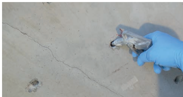
Foto. 2: Czyszczenie otworów
