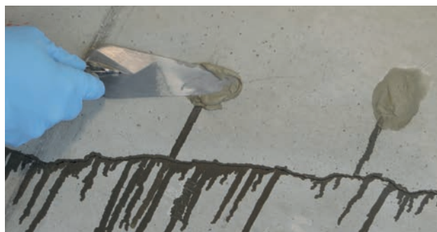
Foto. 6: Zamknięcie otworów po iniektorach
