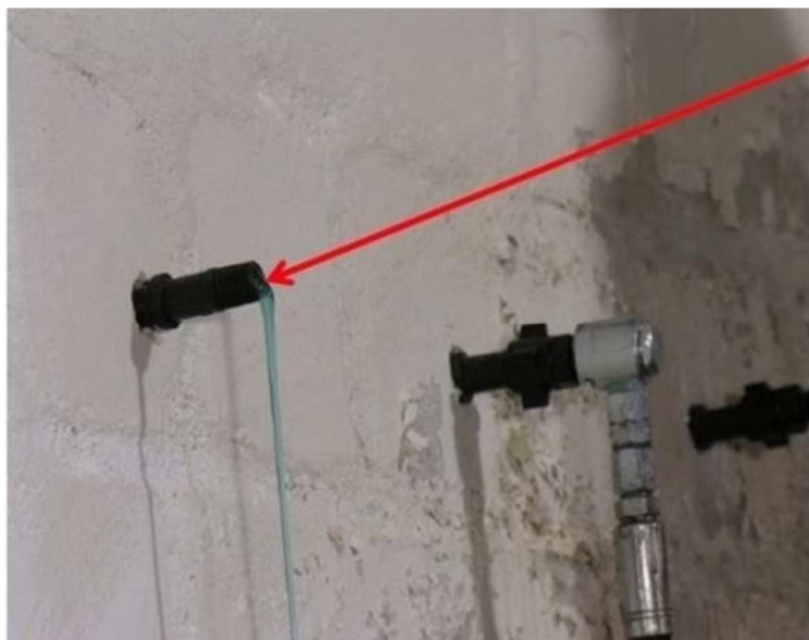
Kontrola rozchodzenia się żelu akrylowego
