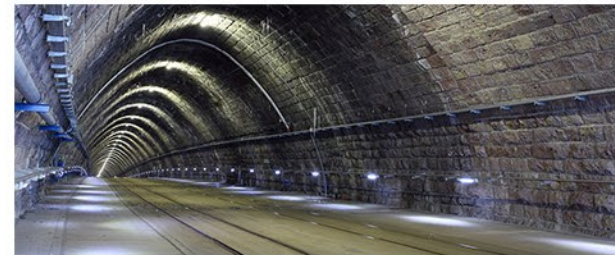
Rys. 4 Tunele są częstym miejscem wykonywania uszczelnień iniekcyjnych
