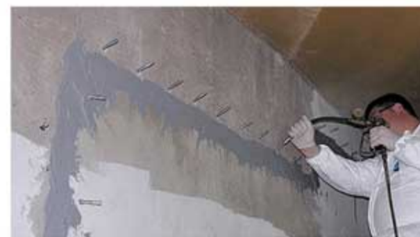
Rys.5 Przykładowy sposób naprawy liniowego spękania konstrukcji z wykorzystaniem żywic epoksydowych WEBAC
