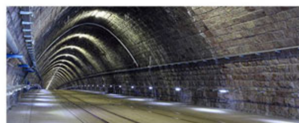
Rys.4 Tunele są częstym miejscem wykonywania uszczelnień iniekcyjnych
