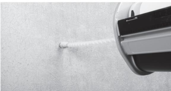
Statkmischer in den Packerstutzen setzen, anpressen und injizieren
