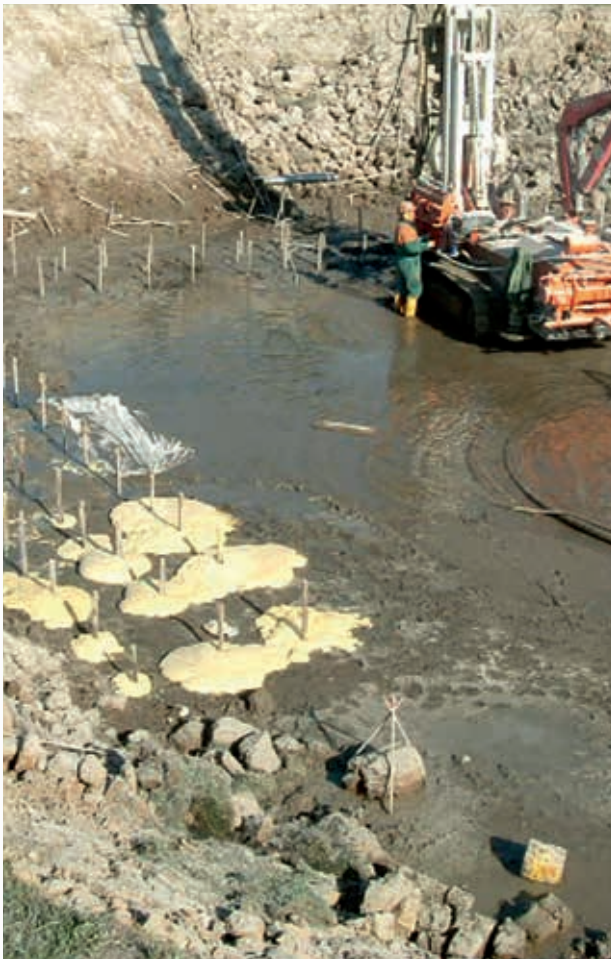
Zastosowanie spienialnej żywicy poliuretanowej WEBAC
