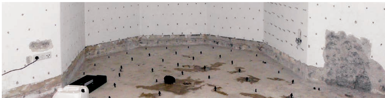
Układ iniektorów w ścianie i podłodze
