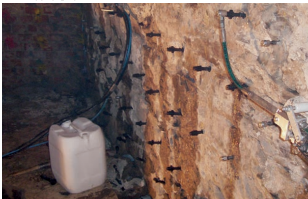
Układ iniektorów przy iniekcji w ścianie z kamienia naturalnego
