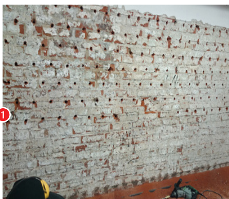
Schemat iniekcji strukturalnej
